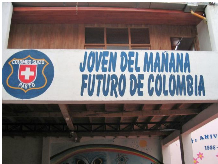
Das Hybrid, welches demoliert werden muss. Hier oben werden zwei Klassenzimmer gebaut werden
