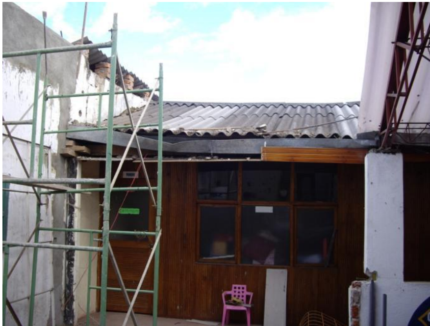
Das erste Schulzimmer des Hybrids, welche demoliert werden muss.
